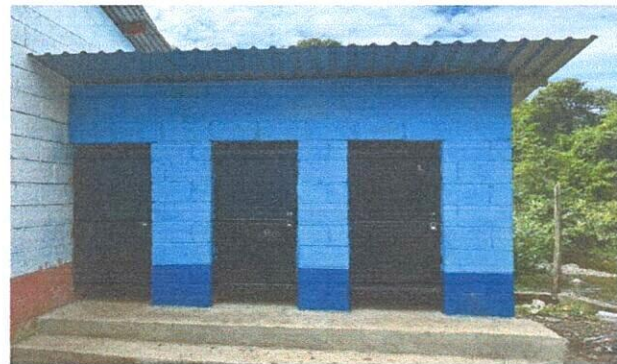
Foto 6: Reparación de red de drenaje y red de agua potable. ✓
