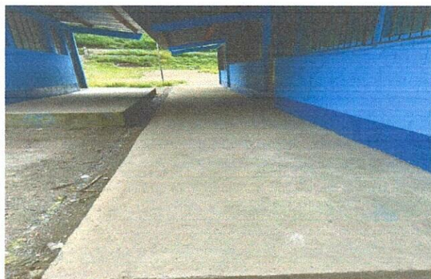
Foto 4: Mejoramiento de piso, mejoramiento de losa de patio.
