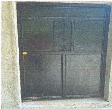
Foto 2: Mejoramiento de puertas.
