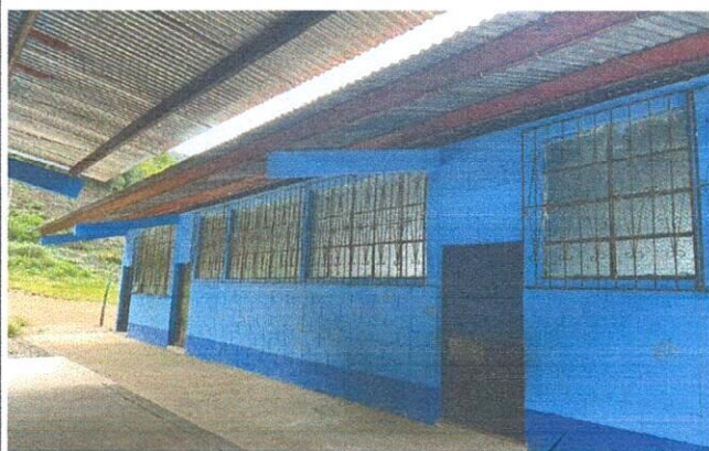
Foto 3: Mejoramiento de ventanas.
