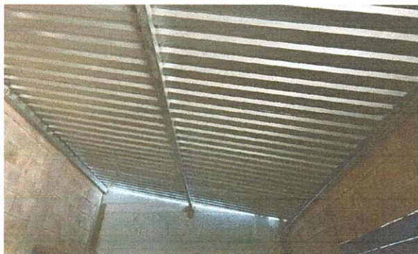
Foto 1: Mejoramiento de estructura de techo, Reparación o sustitución de área de cocina.
